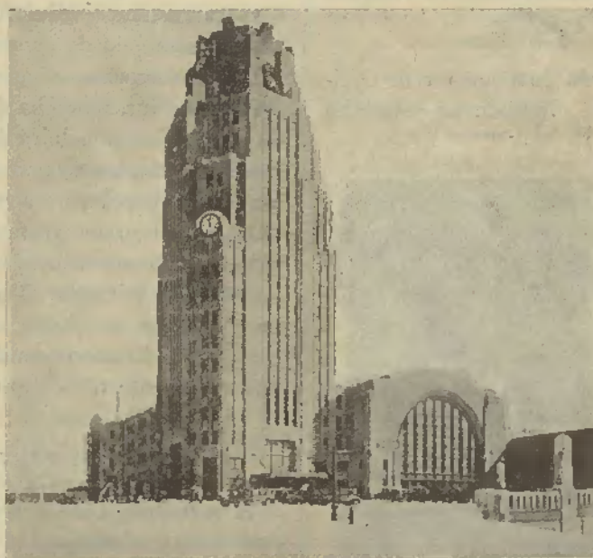
Edifício da estação de Bufalo
