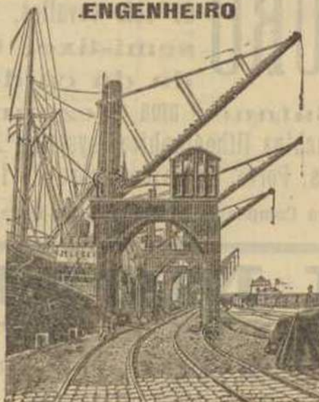
Grua hydraulica com cavalette em uso no porto de Antuerpia
