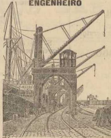
Grua hydraulica com cavaletto em uso no porto de Antuerpia
