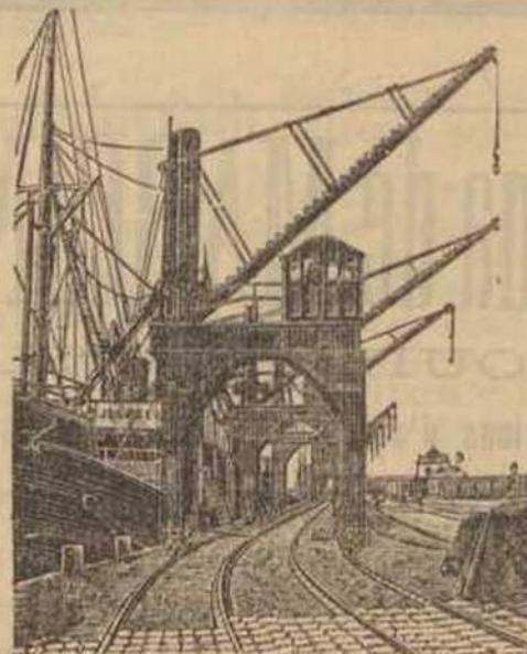
Grua hydraulica com cavalete em uso no porto de Antuerpia
