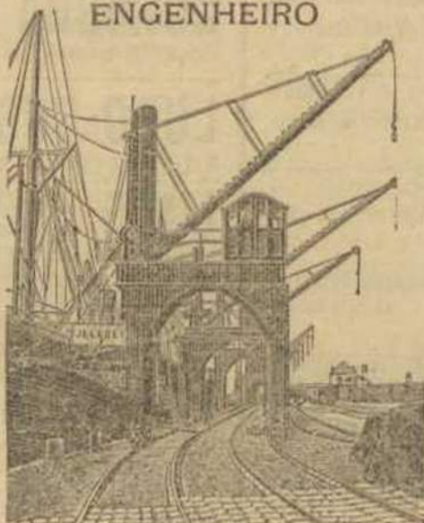
Grua hydraulica com cavaletes em uso no porto de Antuerpia
