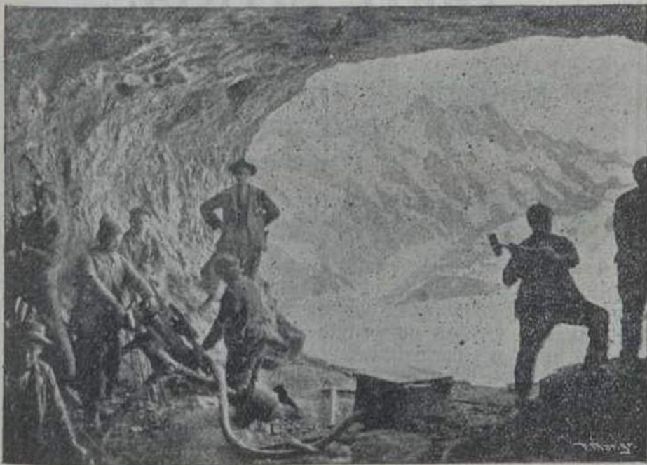
Trabalhos de excavação numa das aberturas da estação d'Elmeier—Perfuradora de percussão Samods de Halsbre e o seu motor electrico
