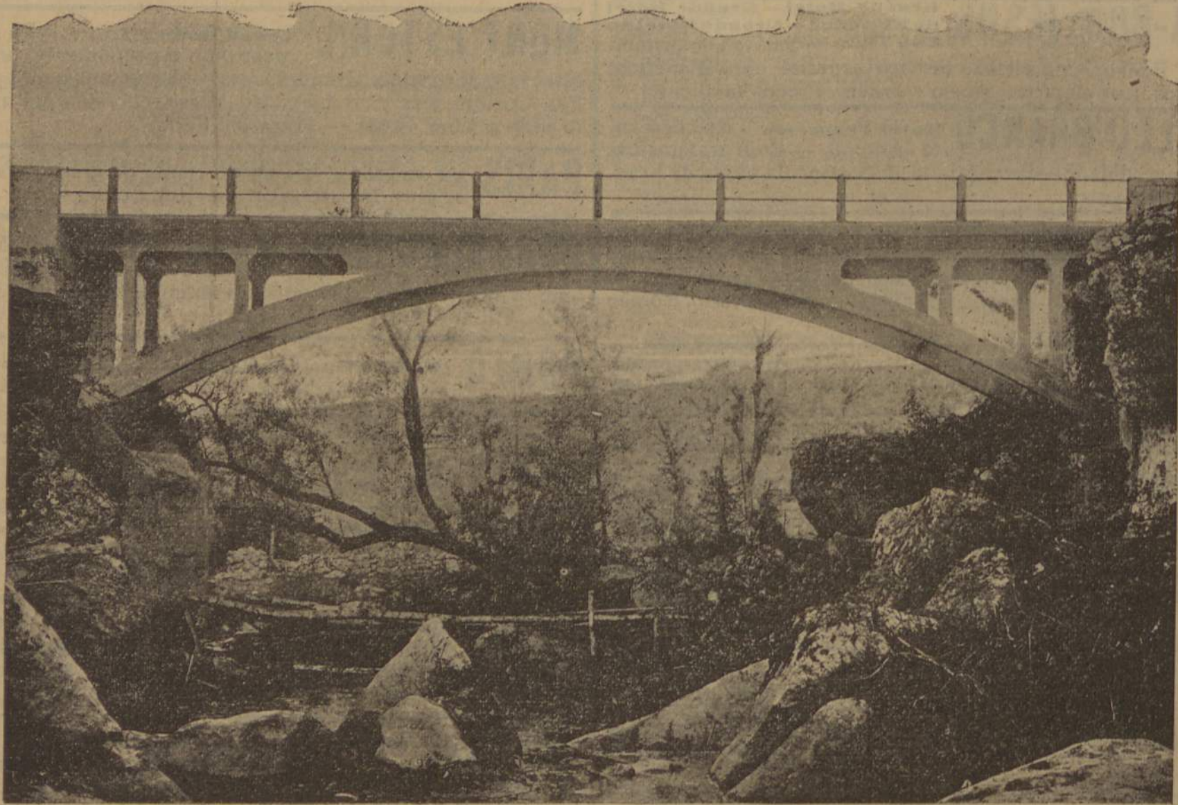
PONTE DO VALLE DE MEÕES — MIRANDELLA (Obra inteiramente em cimento armado, construída em 34 dias. — Vão — 19 metros)
