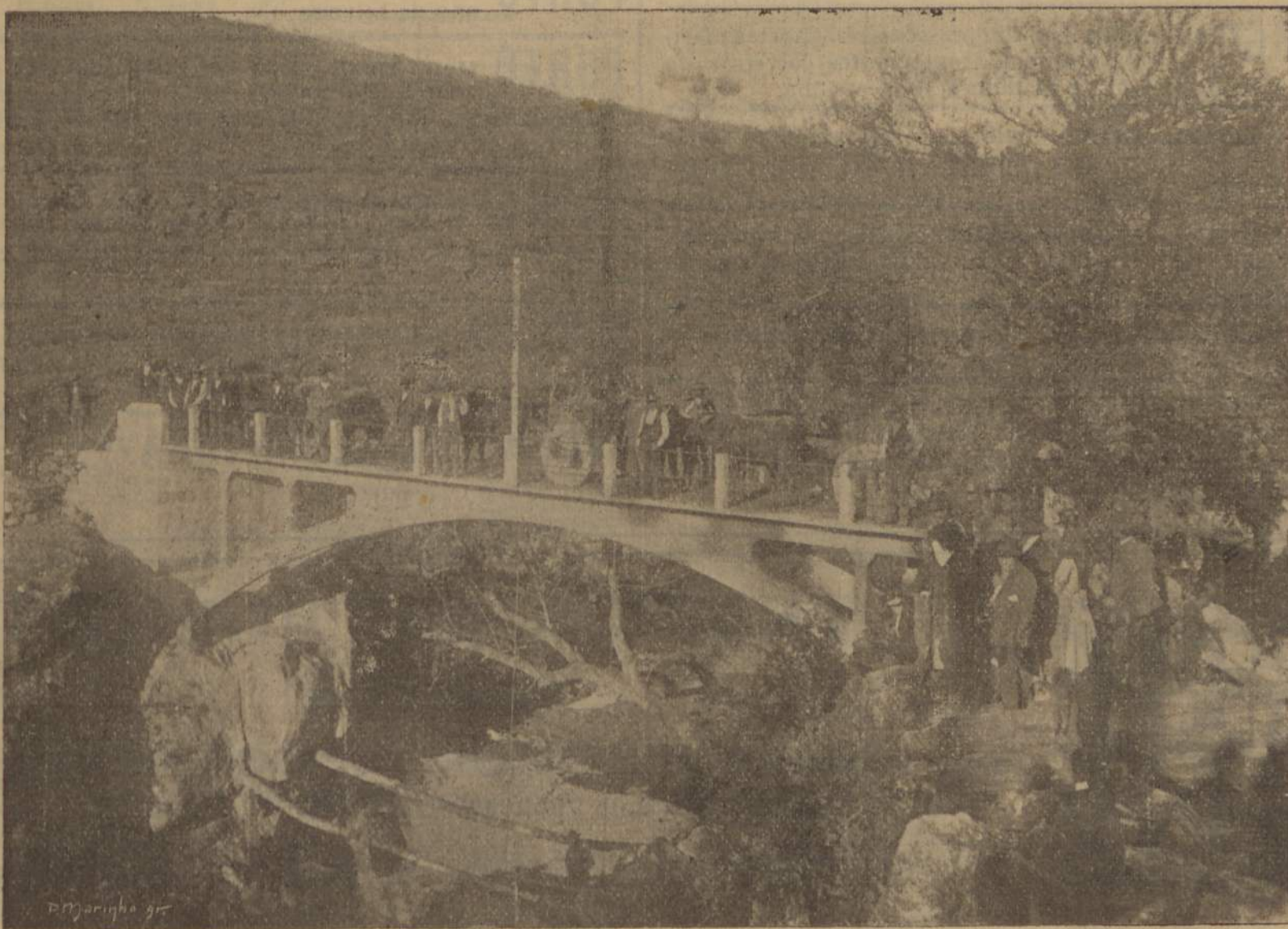
PONTE DO VALLE DE MESES — MIRANDELLA (Obra inteiramente em cimento armado, construída em 34 dias. — Vão—19 metros)
