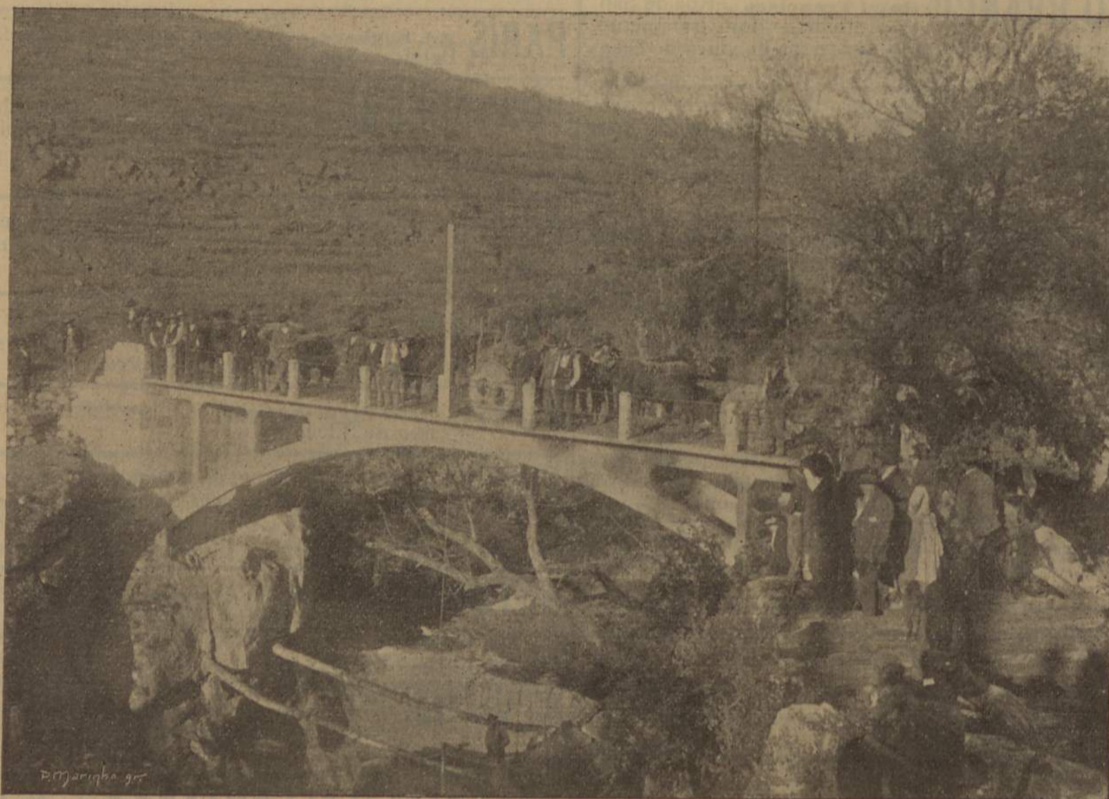
PONTE DO VALLE DE MEÕES — MIRANDELLA (Obra inteiramente em cimento armado, construída em 34 dias. — Vão—19 metros)
