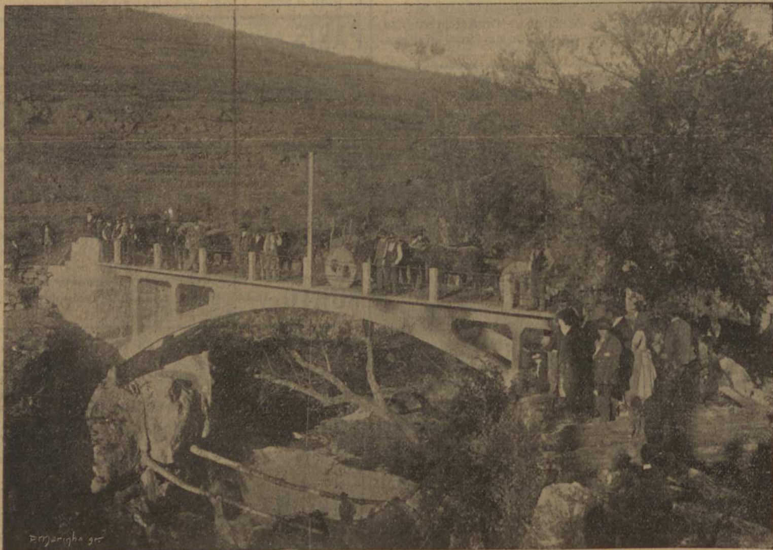
PONTE DO VALLE DE MEÕES — MIRANIELLA (Obra inteiramente em cimento armado, construída em 34 dias. — Vão—19 metros)
