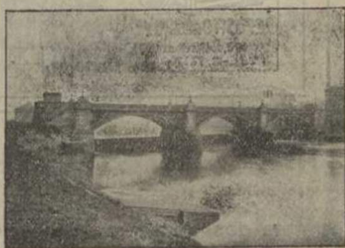
COMPORTAS D'ESTE SYSTEMA ACHAM-SE INSTALLADAS NO GLYDE EM GLASGOW Vão de cada comporta 24,4 metros. Profundidade 3,7 metros. Altura de elevação 9,5 metros
