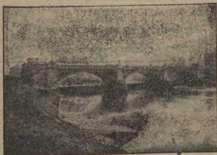
COMPORTAS D'ESTE SYSTEMA ACHAM-SE INSTALLADAS NO CLYDE EM GLASGOW Vão de cada comporta 24,4 metros. Profundidade 3,7 metros. Altura de elevação 9,5 metros
