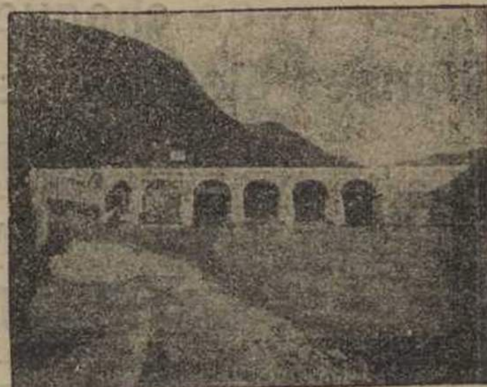
COMPORTAS NO RIO ADDA, ITALIA. Vão de cada comporta 10 metros. Profundidade de cada comporta 9,2 metros. Altura de elevação 4,3 metros.
