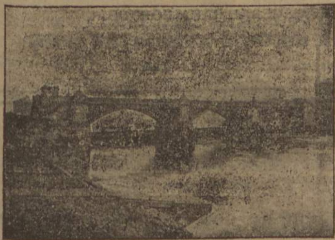
COMPORTAS D'ESTE SYSTEMA ACHAM-SE INSTALLADAS NO CLYDE EM GLASGOW Vão de cada comporta 21,4 metros. Profundidade 3,7 metros. Altura de elevação 9,5 metros
