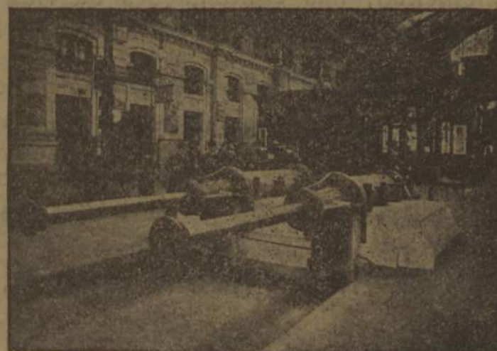
Appareilhydraulico de parada, de curso de 7 pes fornecido ao Caminho de Ferro Paris-Orleans
