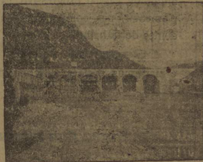
COMPORTAS NO RIO ADDA, ITALIA, Vão de cada comporta 10 metros. Profundidade de cada comporta 9,2 metros. Altura de elevação 4,3 metros.
