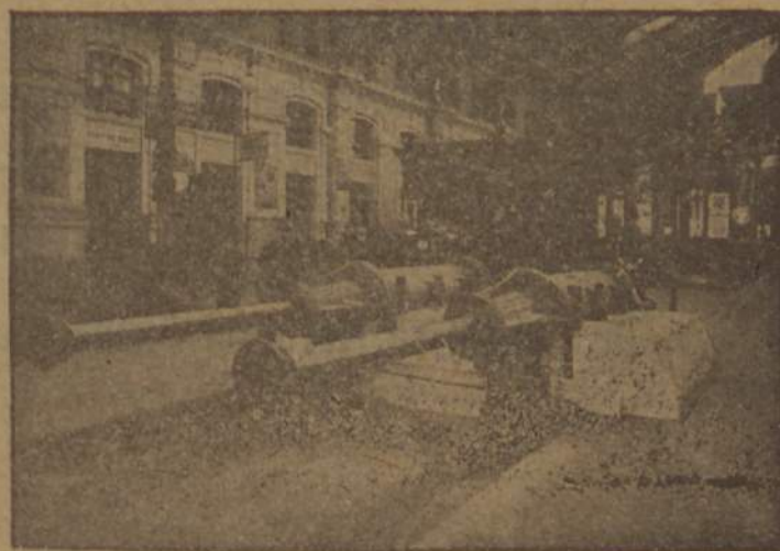
Appareilhydraulico de parada, de curso de 7 pés, fornecido ao Caminho de Ferro Paris-Orleans
