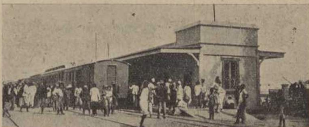
Estação de Benguela
