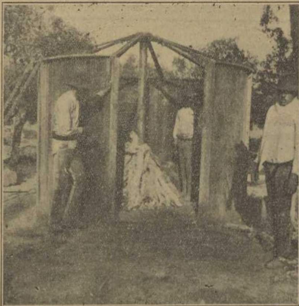
Fôrno «Trihan», tipo «Automatic». Carregando o fôrno
