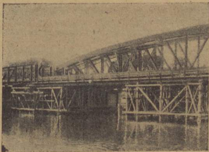
O tramo parabólico da nova ponte, vendo-se os pilares provisórios em madeira
