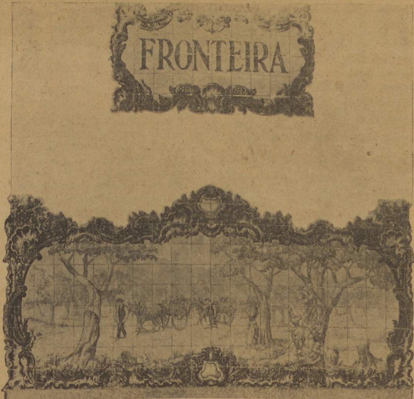
Um dos painéis de azulejo colocados no edificio da estação de Fronteira
