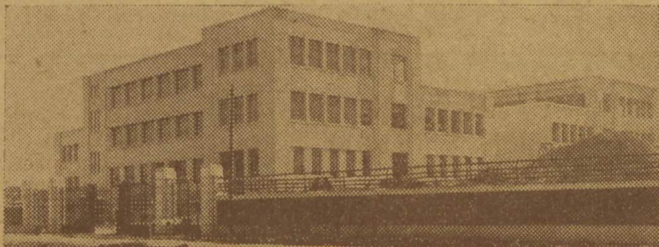
AS TRAZEIRAS DO EDIFICIO DO TECNICO
