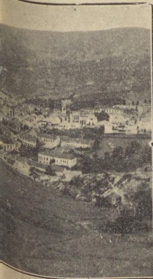
(Em cima)—Vista geral
