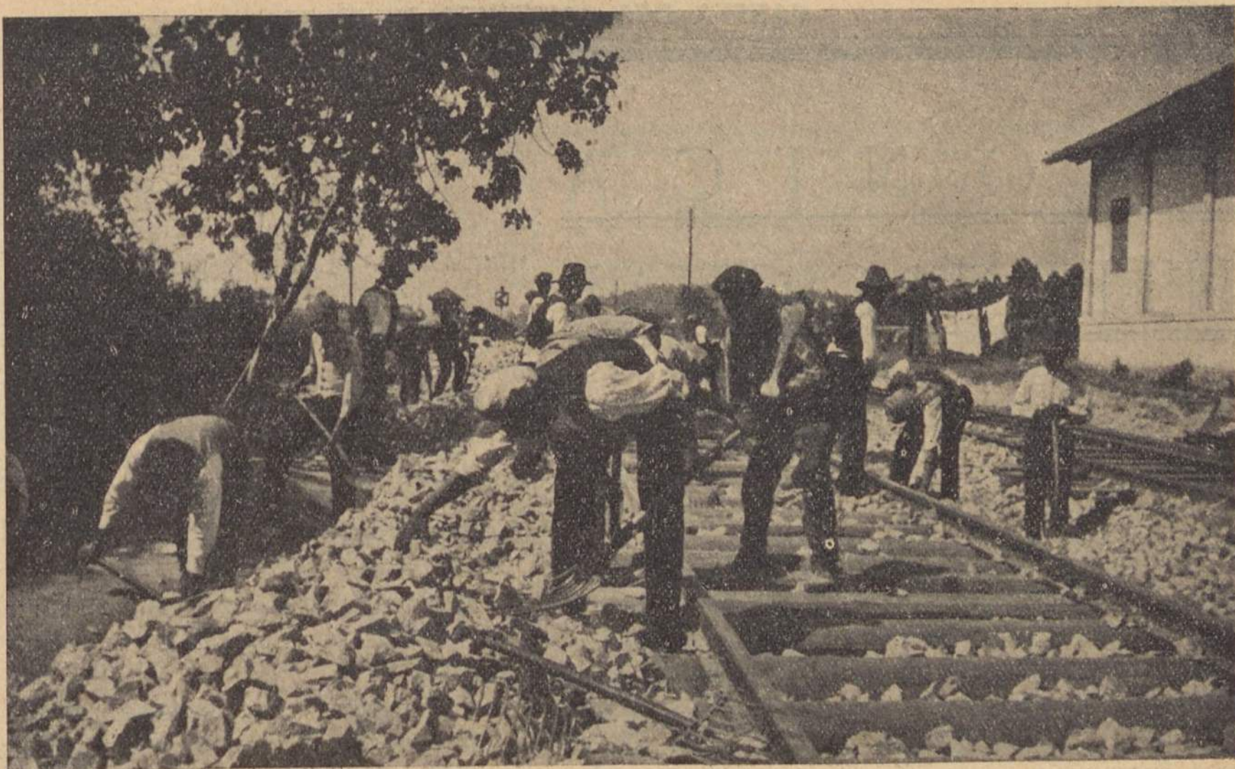
2. a via Contu- mil-Ermezinde Trabalhos de balastragem
