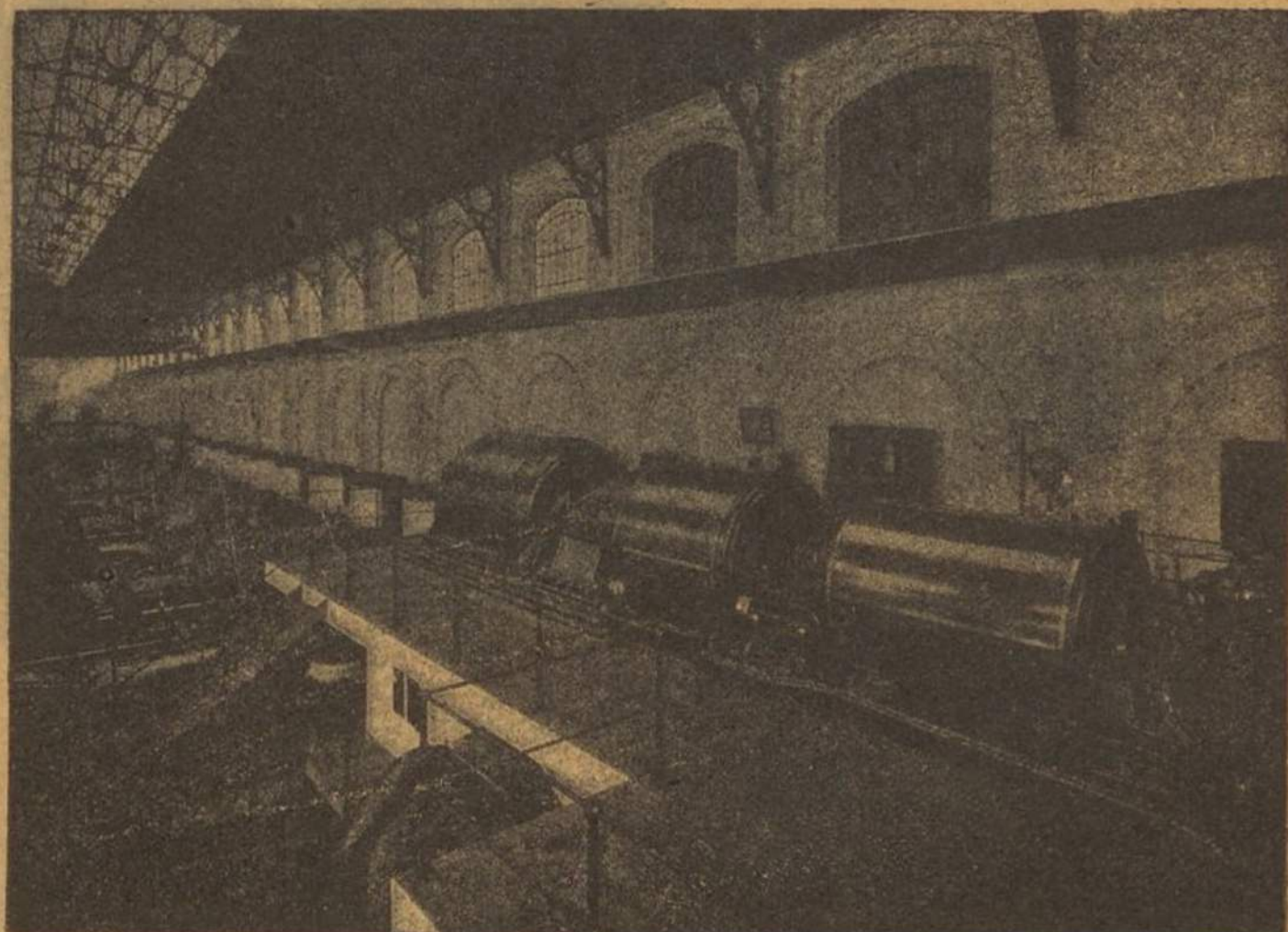
O turbo grupo a vapor de 5.000 kilowatts da Central de Massarelos da Companhia Caminhos de Ferro do Porto
