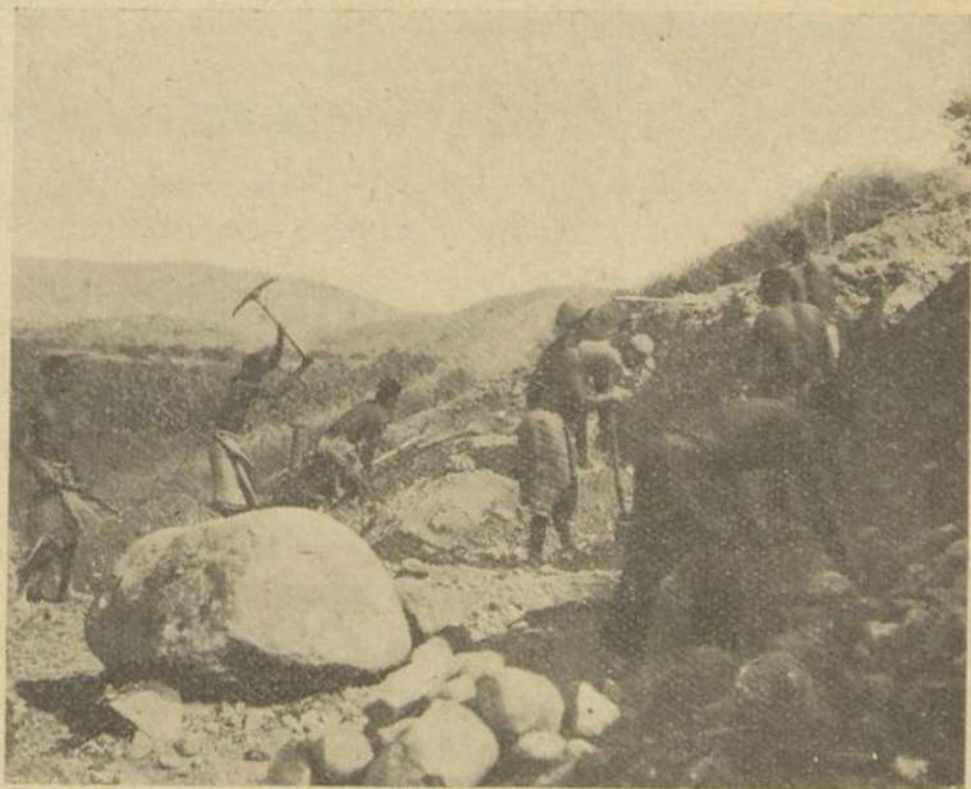
VARIANTE DO LENGUE—Corte da plataforma em meia encosta
