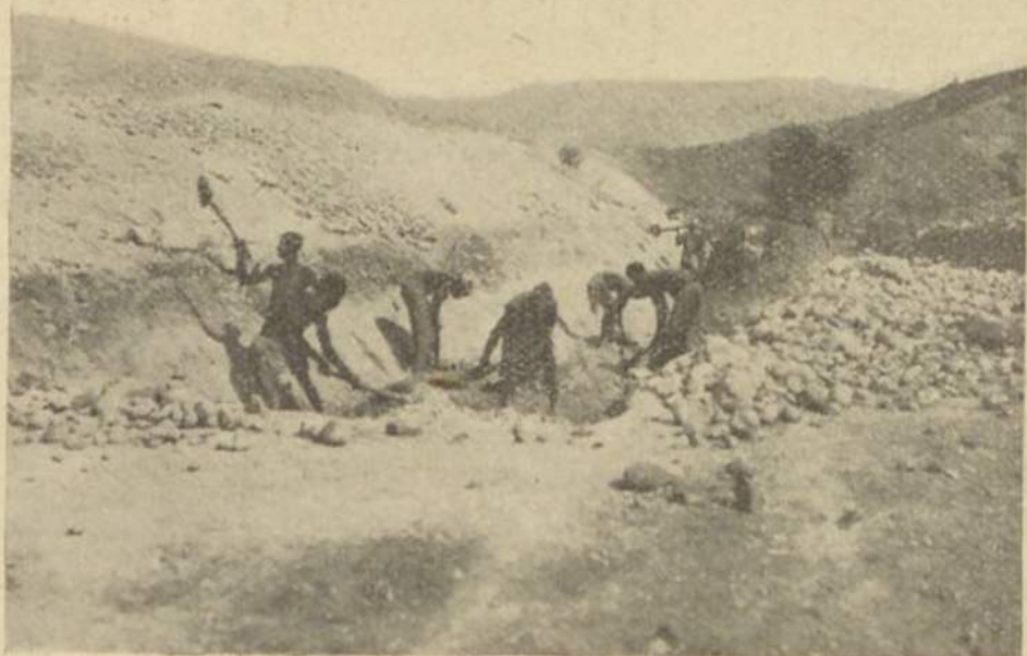
VARIANTE DO LENGUE — Trincheira e cursa de acesso à ponte
