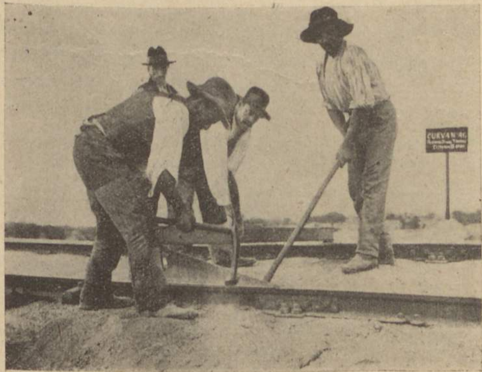
Nivelamento da via em curva
