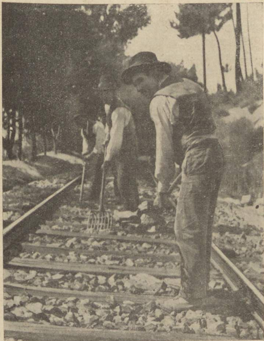
Depuração do balastro por meio de forquilhas
