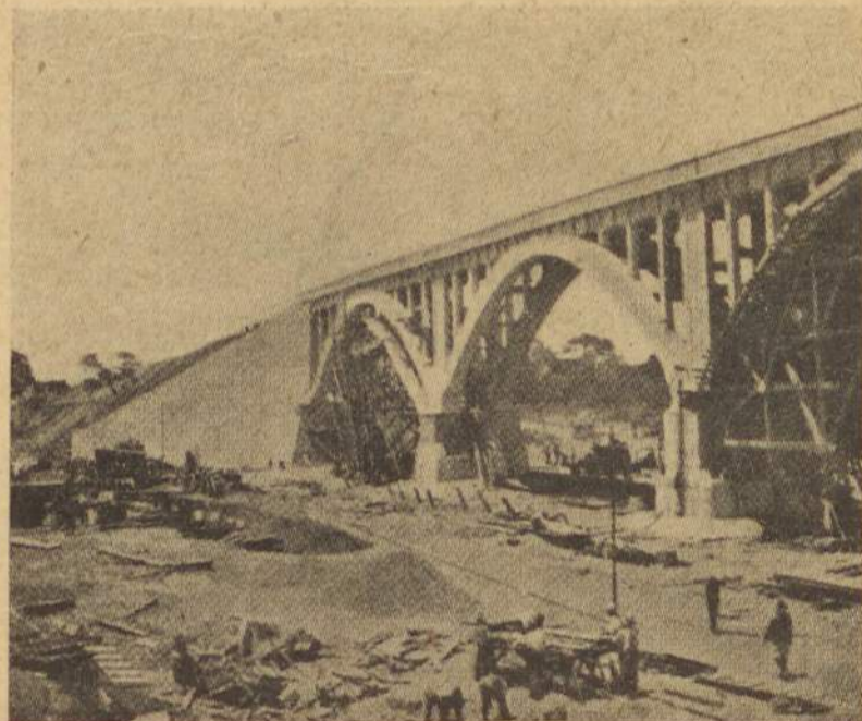
Ponte General Carmona (em construção)
