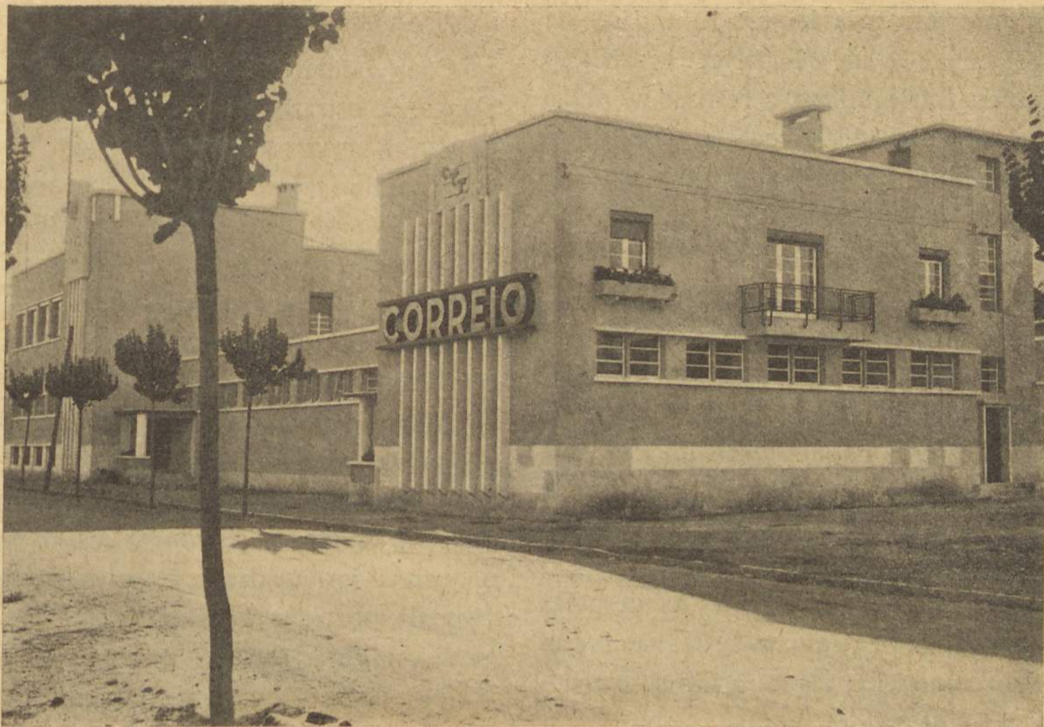
CTT—ESTAÇÃO DE TORRES NOVAS
