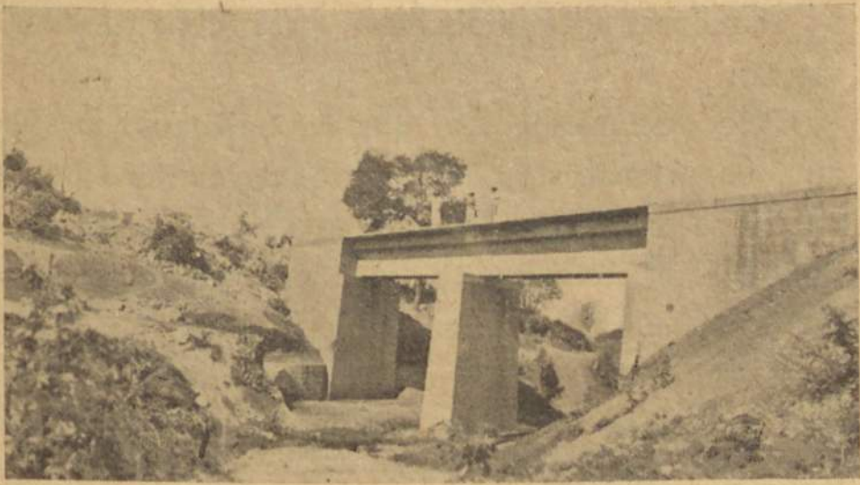
CAMINHO DE FERRO DE TETE — Ponte de 25 m ao quilómetro 8,075
