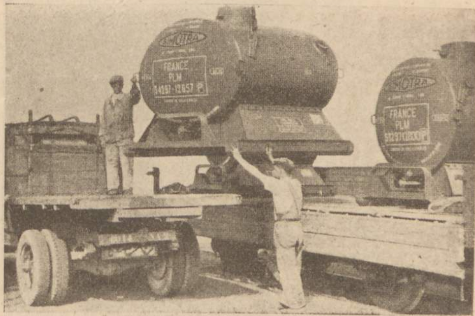
Transbordo de «container-cisterna» de vagão para camião
