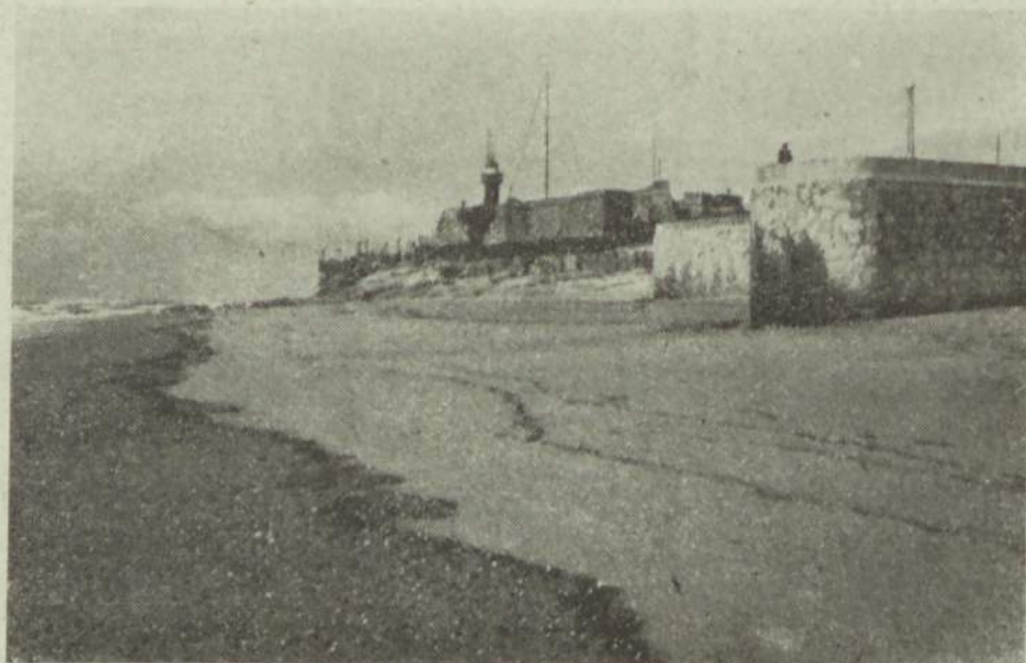
Assoreamento junto à barra do pôrto—lado norte— em frente do Forte de Santa Catarina
