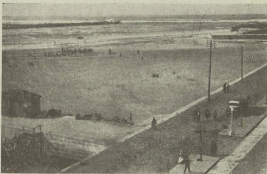
Fotografia expressiva do estado em que se encontra o assoreamento do pôrto e barra formado, apenas, por um pequeno canal
