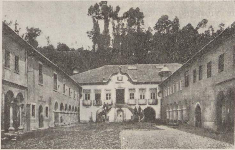
AMARANTE — Edifício dos Paços do Concelho
