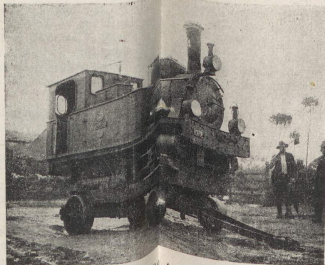
LINHA DA SENHORA DA HORA A TROFA:— Condução duma loco- motiva por estrada
