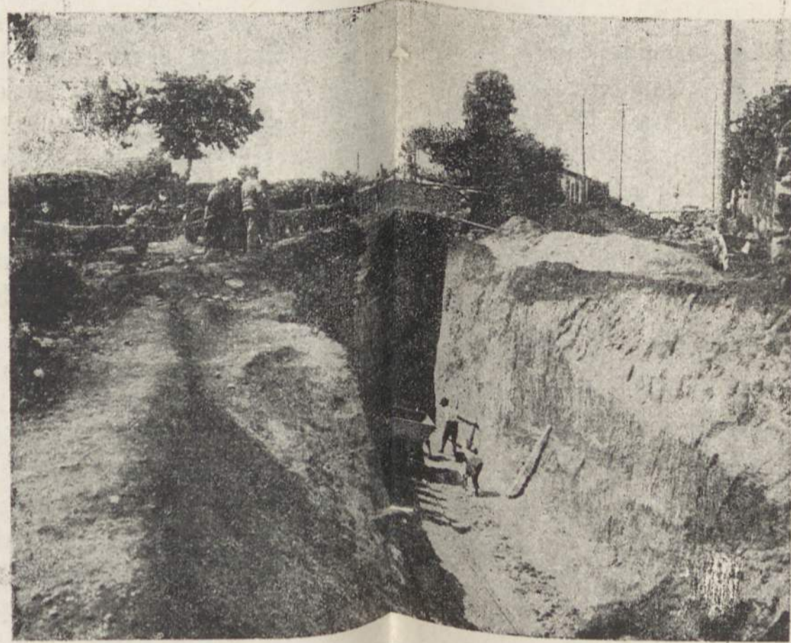
LINHA DA SENHORA DA HORA A TROFA:— Construção duma trincheira
