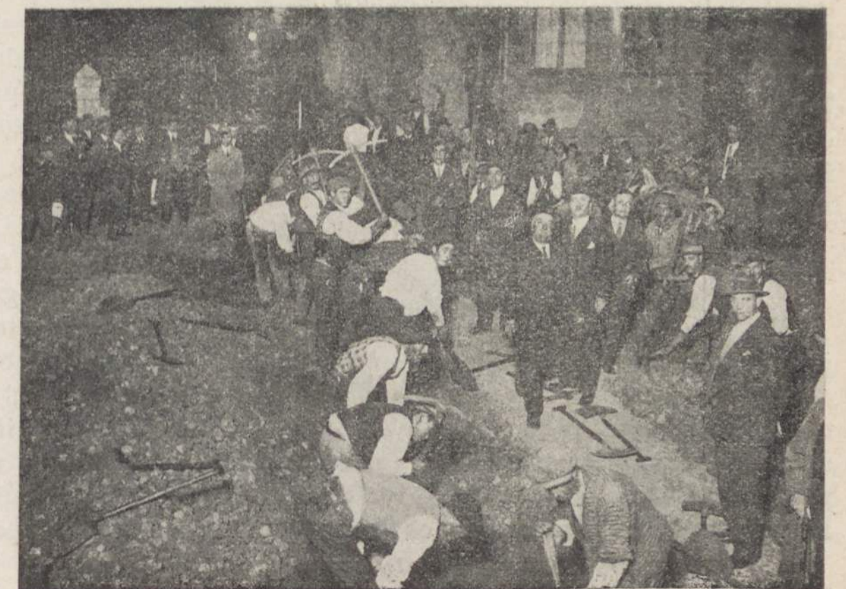
LINHA DA TRINDADE:— Assentamento de via em trabalhos nocturnos
