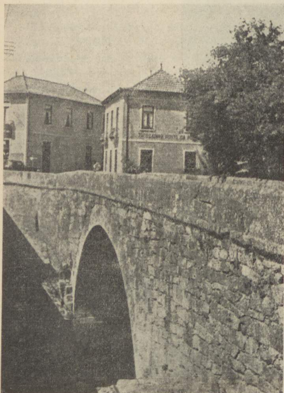
PONTE-DE-PEDRA (Antiga «ponte petrina»)
