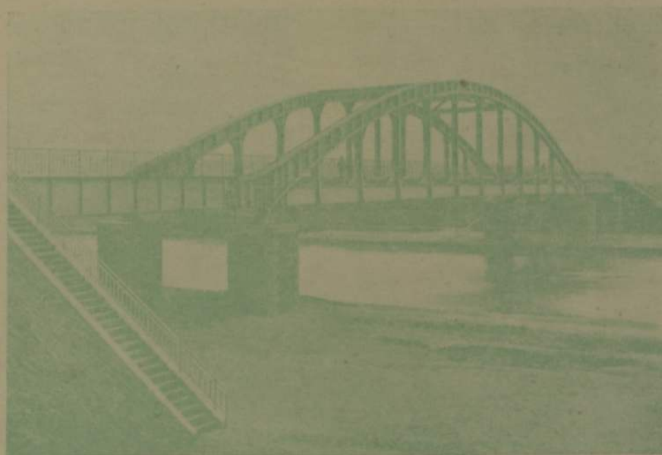
Ponte, inteiramente soldada, em Stochroye, sobre o Canal Alberto
