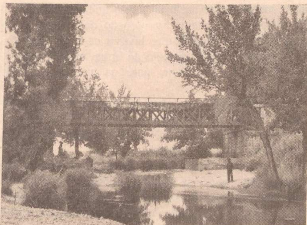
Ponte sobre o Caiola
