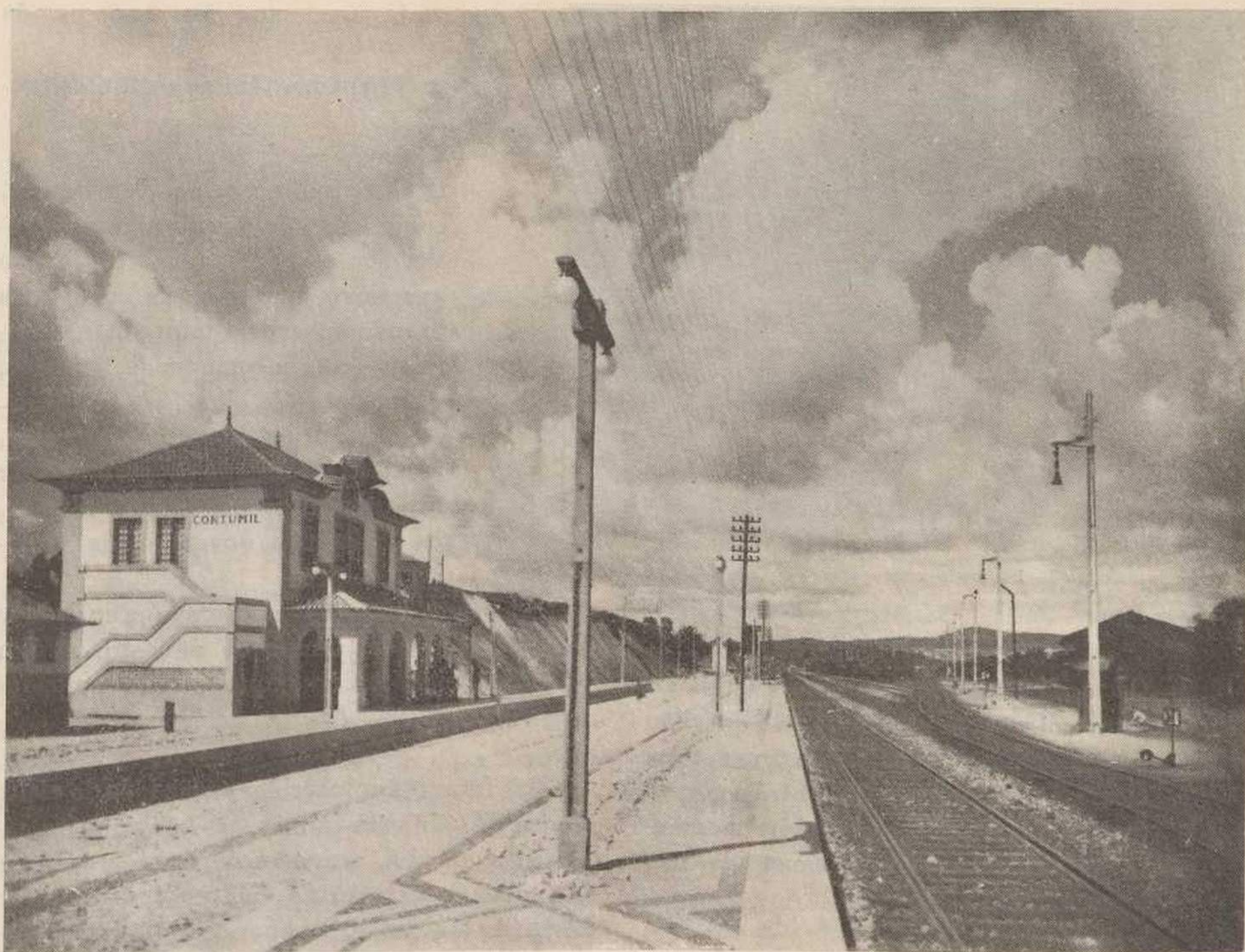
Contumil — Nas linhas, lâmpadas de vapor de sódio e no cais desembarque, lâmpadas normais
