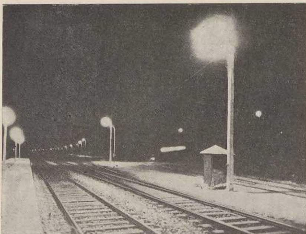
Contumil — Iluminação com lâmpadas de vapor de sódio
