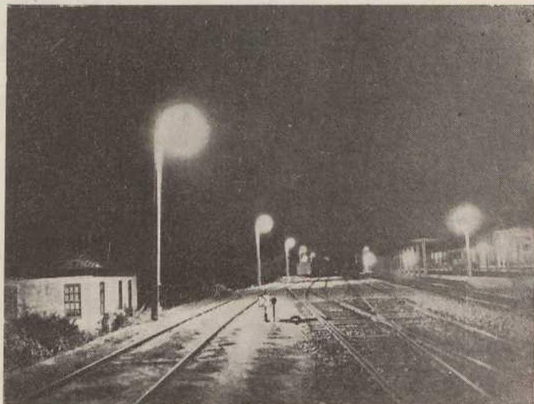
Ermezinde — Iluminação com lâmpadas de vapor de sódio
