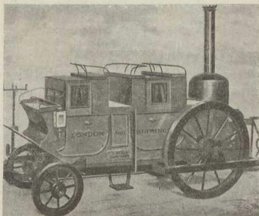
Automóvel a vapor de F. Hill, construído em Birmingham (1830) (Modelo de C. Biscaretti)
