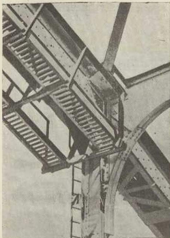
Um «nó» das vigas durante a montagem
