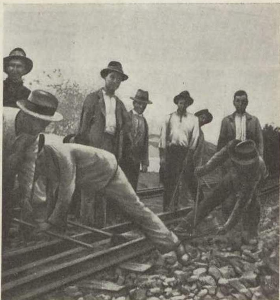
O «tombo» dos carris da fila direita. À direita vê-se um dos dois homens que enfiando as bitas nos furos extremos de um grupo de 10 carris tombaram com a ajuda de algumas alavancas todos os carris dessa fila no mesmo espaço de tempo que os da outra
