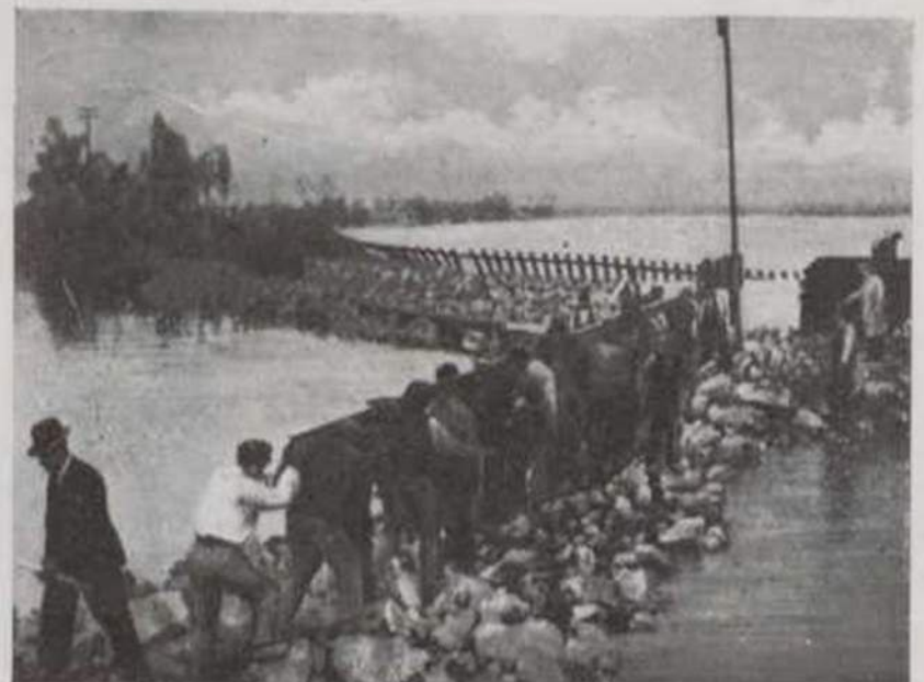
O pessoal trabalha activamente na reconstrução da linha no local do rombo da linha de Vendas Novas
