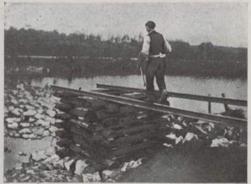
Comêço da reconstrução da linha de Vendas Novas, no local do grande rombo. A linha assenta, provisoriamente, em pilhas de travessas
