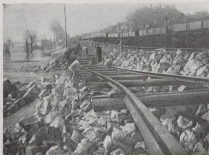
Na linha descendente do Leste, um comboio de serviço descarrega pedra de alvenaria
