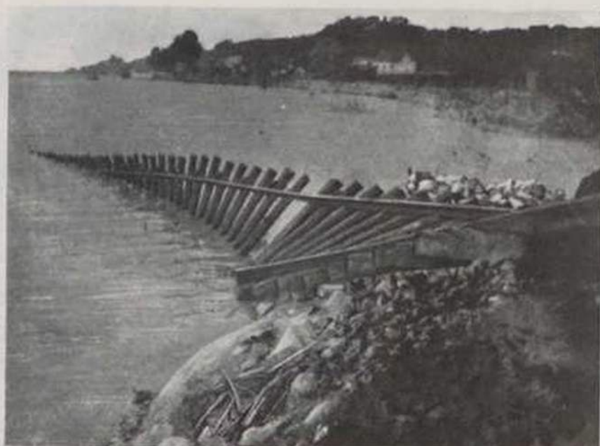
A linha de Vendas Novas foi quebrada e arrastada pela corrente para juzante
