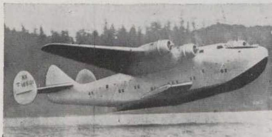
Fig. 175 — Hidro-avião transoceânico para 40 ou 74 passageiros — Envergadura: 46 m ,32; comprimento: 32 m ,30; 4 motores com a potência total de 6000 C.V. Peso em carga: 37,420 Ton. Velocidade de cruzeiro: 265 Km./h. Distância franqueável com 40 passageiros: 5.000 Km.
