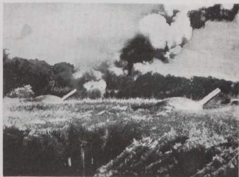
Canhões da linha Magnot em acção, protegidos por cúpulas de aço e formigão armado que apenas emergem do solo.
