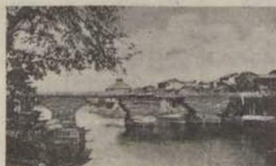
Provincia de Caxemira (Índia): Ponte de Srinagar. Os alicerces ou ensoleiramentos dos pilares são velhos barcos cheios de pedras; sobre estes levantam-se pilhas de madeiros, cada vez maiores à medida que se elevam, de forma que os vãos a transpor pelo tabuleiro sejam os menores possíveis.
