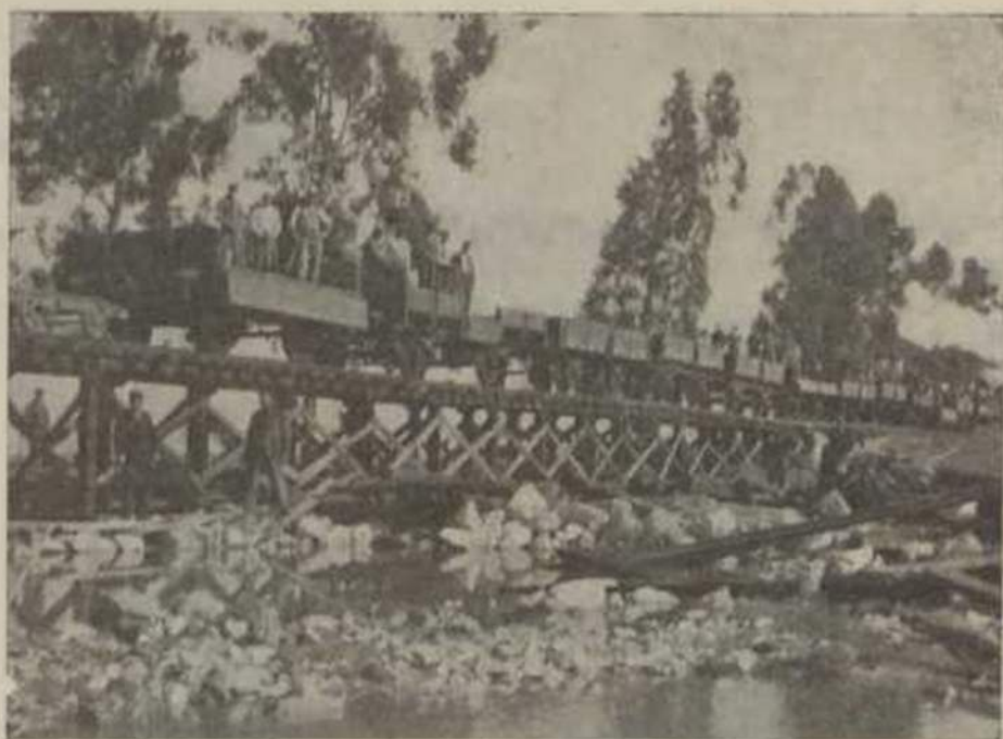
Cavalete de madeira na linha de Vendas Novas, para ataque dos rombos produzidos pelas águas no atêrro junto do Setil.
