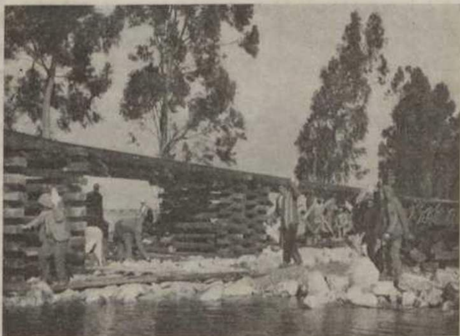
Cavalete armado com travessas para suportar a via por onde seguiam os vagões carregados de pedra para ataque dos rombos no Setil.
