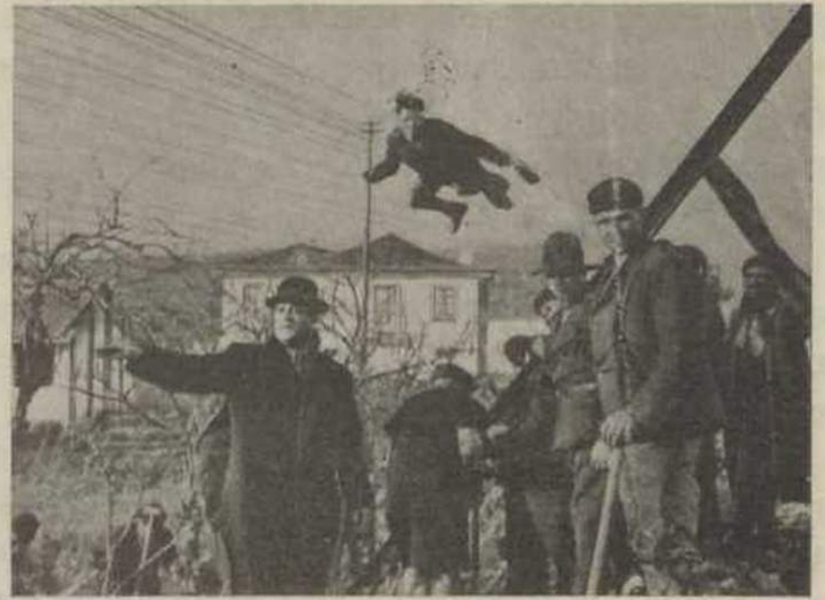
Curiosíssima fotografia que mostra um Guarda-fios deitado sobre as linhas aéreas do traçado telegráfico dos Correios, a-fim-de, com o seu peso, facilitar a libertação das linhas da Companhia que se embaraçaram com o traçado acima referido, entre Alhandra e Vila Franca.
