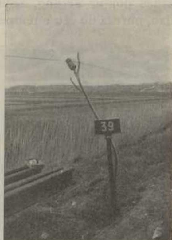
Ao Km. 39 da linha de Leste até se arvorou de poste provisório o destroço feito pelo ciclone nas árvores que próximo existiam.
