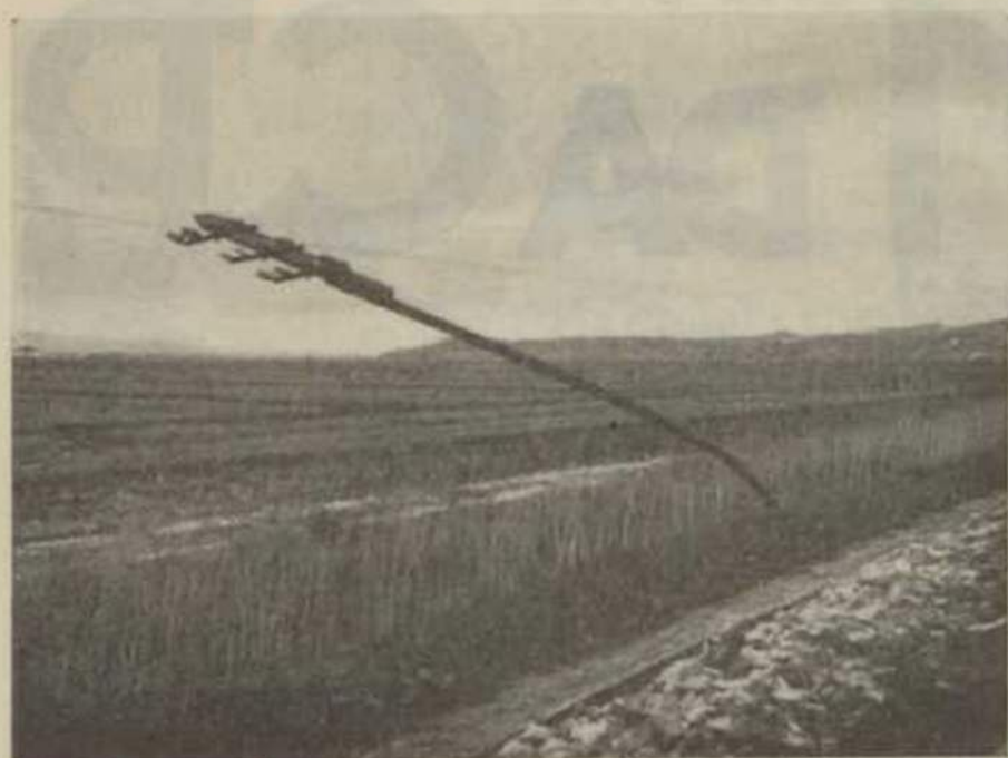
Quando se iniciou a reconstituição do traçado telegráfico da Companhia aproveitaram-se provisoriamente os postes, fôsse qual fôsse o seu estado ou posição. Este poste, apesar de tudo, suporta já um fio telegráfico.
