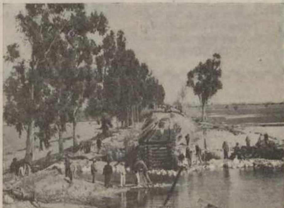
Cavalete de madeira que suporta a via e comboio de serviço com pedra para ataque dos rombos no Setil.
