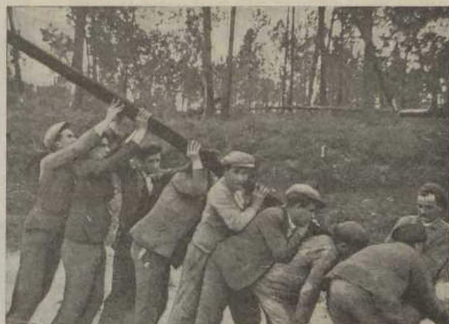
Entre Caxarias e Albergaria. Levantando um poste com 240 Kgs. de peso.
