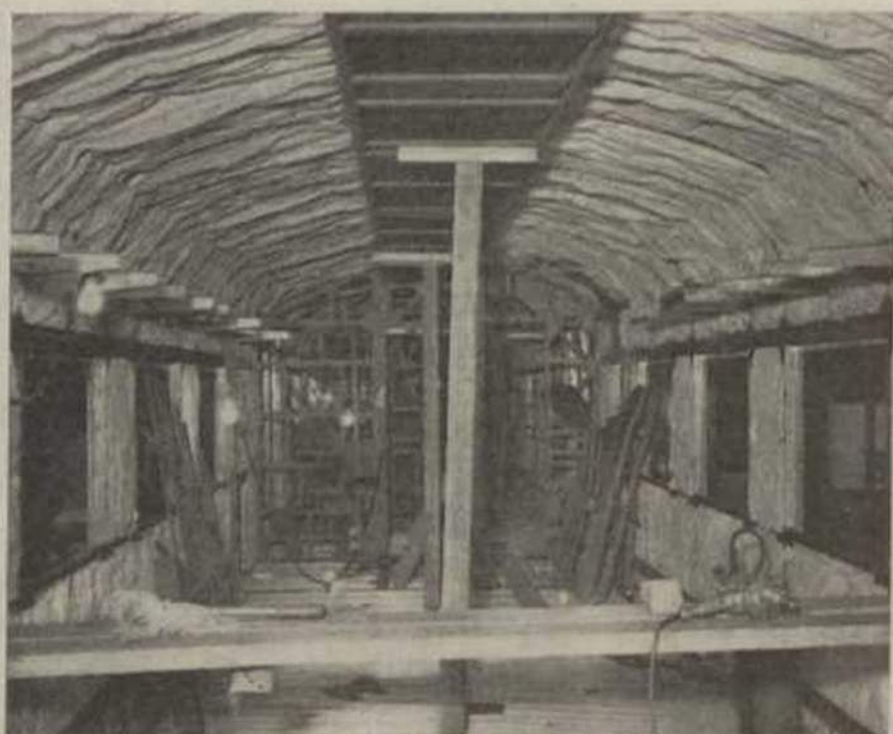
Montagem das divisórias interiores e da conduta de ventilação, depois de colocado o isolamento de algodão de vidro
