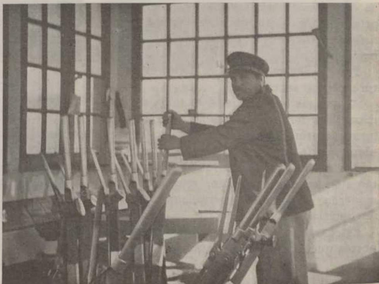
Vista interior dum dos postos de manobra e encravamento de agulhas — tipo Saxby — de Entroncamento.
