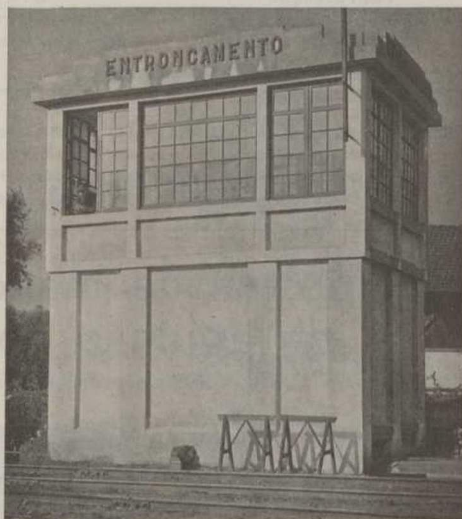
Pôsto de manobras de agulhas e sinais — tipo Saxby — depois de remodelado.
