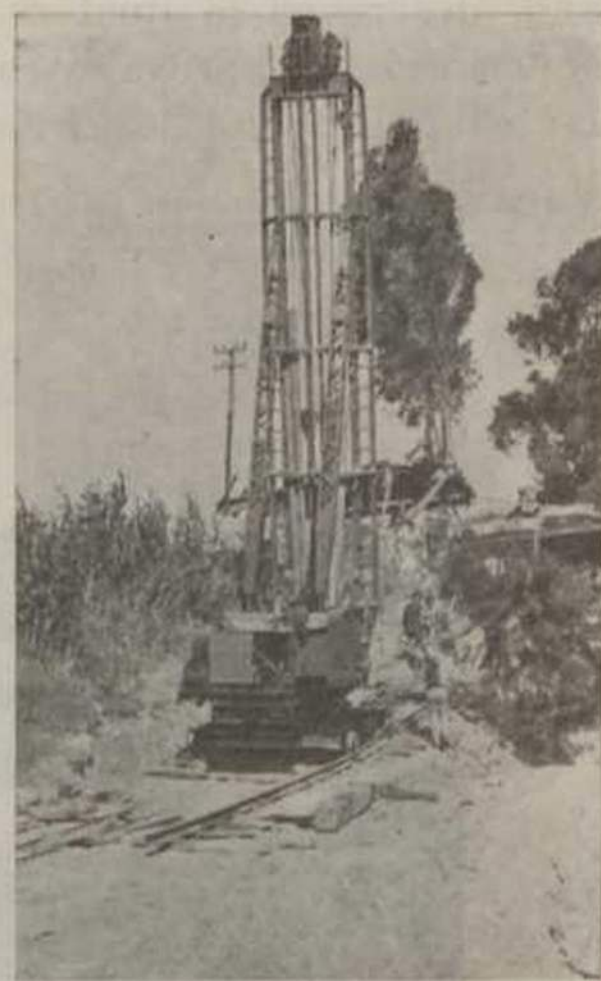
A máquina da casa Franki que cravou as estacas de betão armado onde se apoiará o novo encontro da ponte do Canal da Azambuja.
