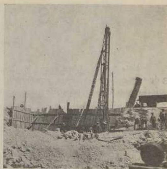
A grande máquina para cravação de estacas da casa Franki trabalhando nos alicerces para o viaduto de alvenaria ao Km. 56,650 da linha de Leste.
