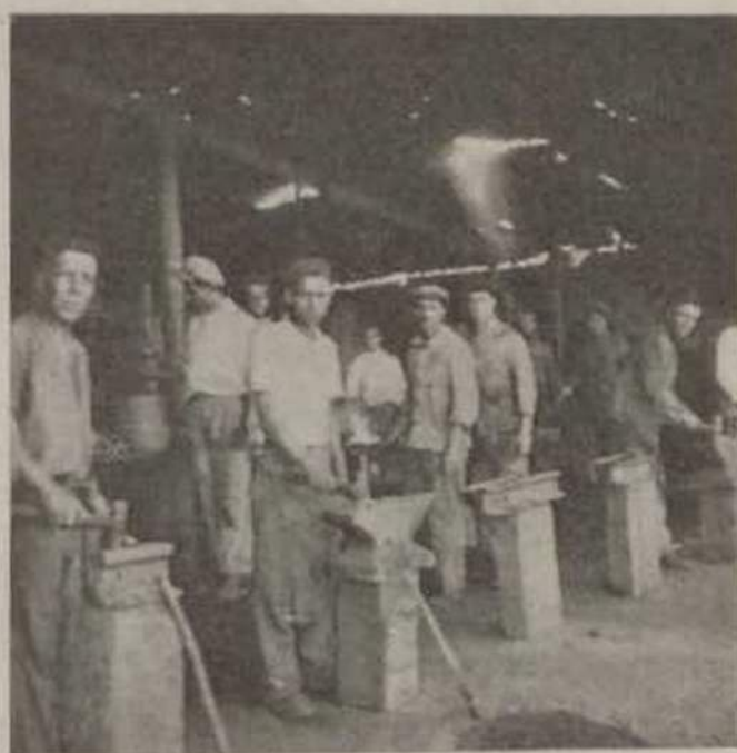
O granito para a cantaria das obras do Setil é muito bom, azulado, de grão fino mas rijíssimo. As ferramentas necessitam ser constantemente reparadas. Nesta improvisada oficina de ferreiro os operários não têm mãos a medir nem tempo a perder, mas consentiram em pousar para o fotógrafo...
