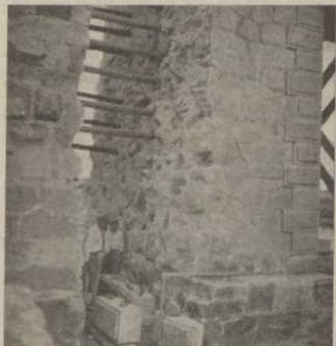
Pormenor do corte do antigo encontro poente da ponte do Canal da Azambuja para o transformar em pilar
