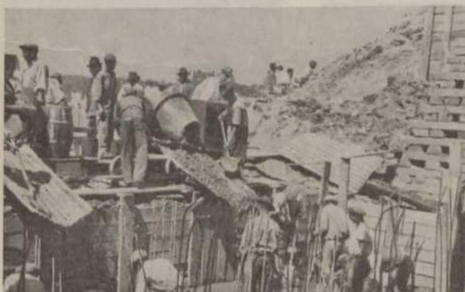
Betoneiras despejam sem cessar betão para a elaboração da sapata do futuro encontro da ponte do Canal da Azambuja.
