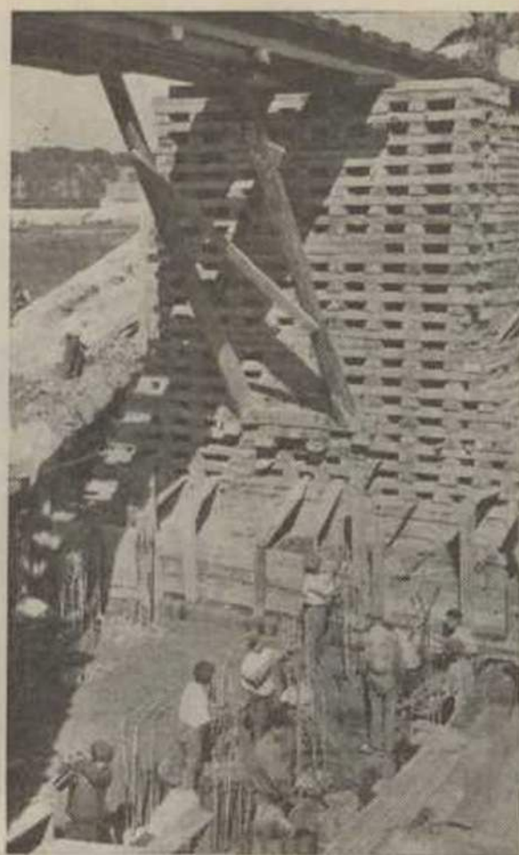
Execução da sapata para o novo encontro da ponte do Canal da Azambuja.
