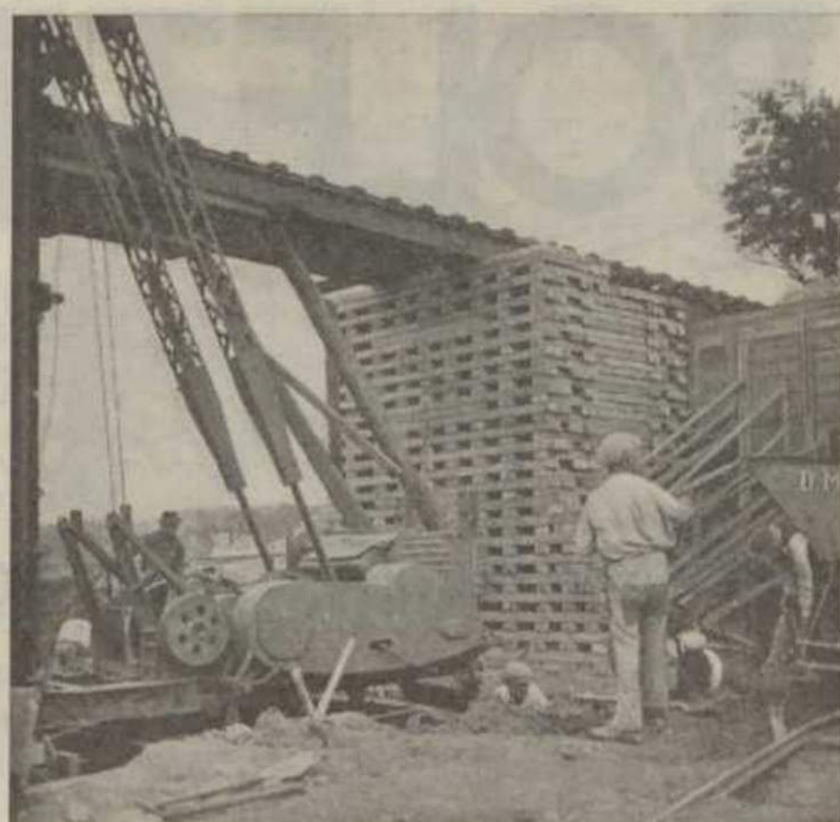
Ampliação da ponte do Canal da Azambuja. Uma das pilhas de mil travessas.
