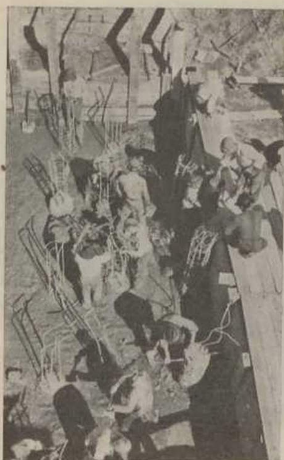
Execução da sapata onde assentará o novo encontro da ponte do Canal da Azambuja, depois de ampliada com mais um tramo de 36 metros de vão.
