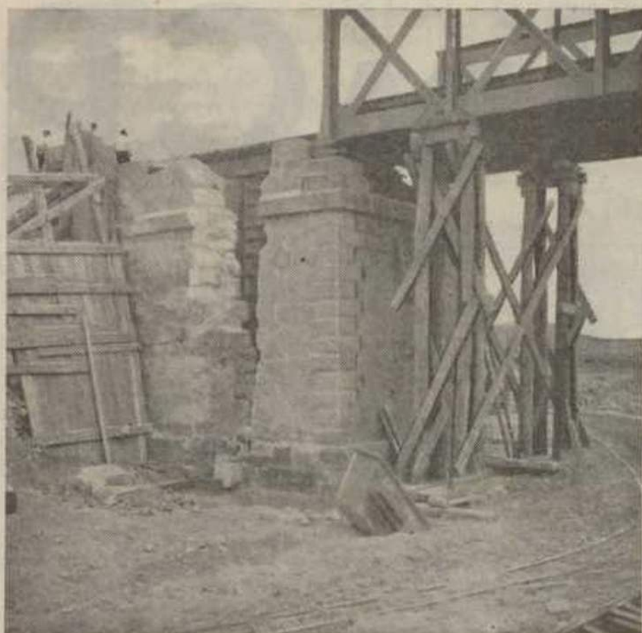
O velho encontro poente da ponte do Canal da Azambuja já está cortado para ser transformado em pilar.
