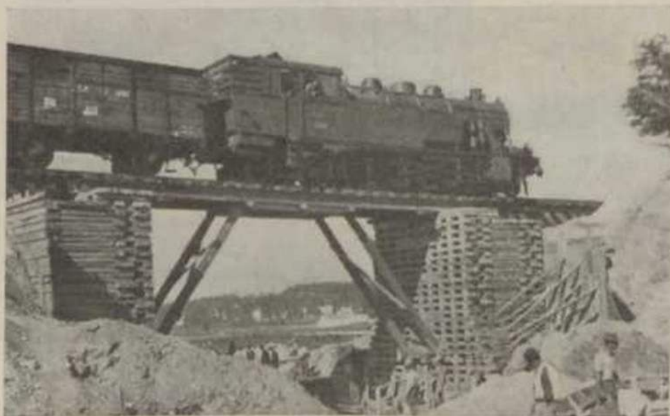
O pontão provisório de 12 metros de vão apesar do seu aspecto ligeiro é de robustez a toda a prova como se vê.
