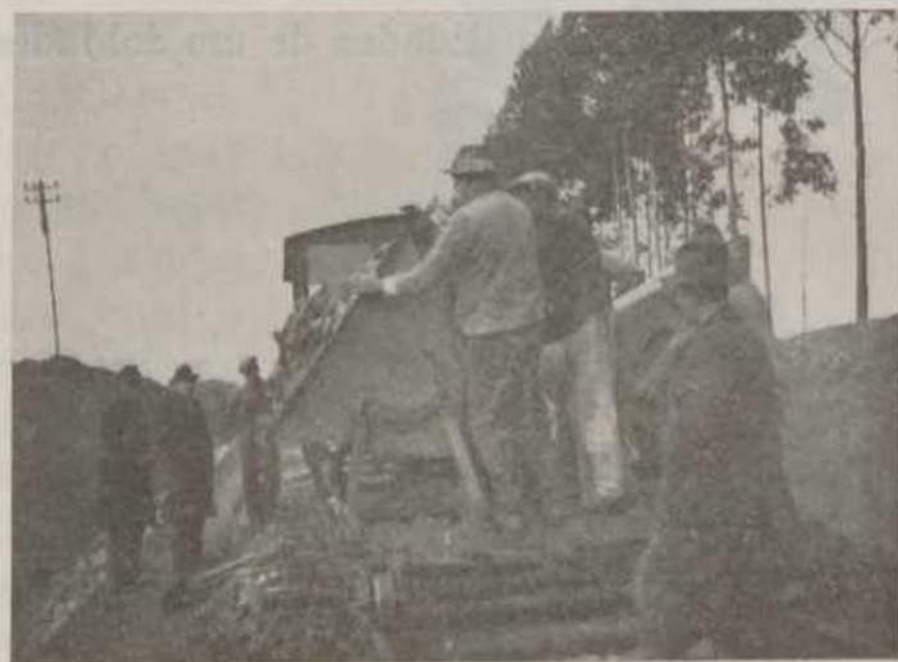
Descarga rápida do balastro
