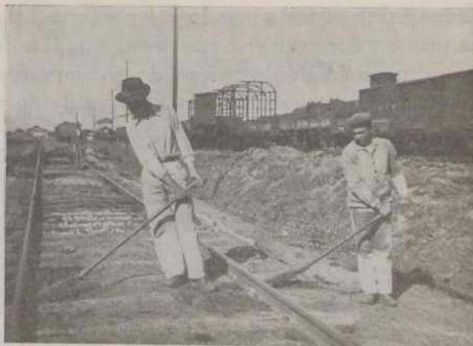
Os alinhadores de via Abtus permitem corrigir um alinhamento com grande facilidade e rapidez.
