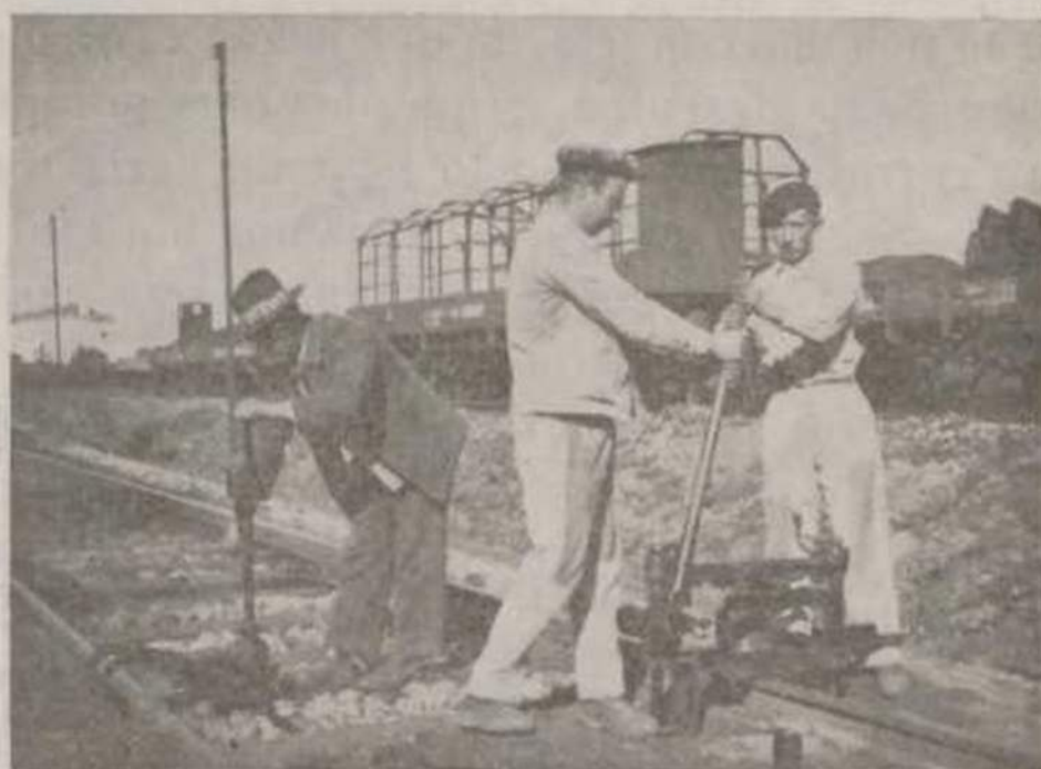
A serra Robel (à direita) e a máquina de furar carris Robel (à esquerda) permitem serviços rápidos e muito perfectos.
