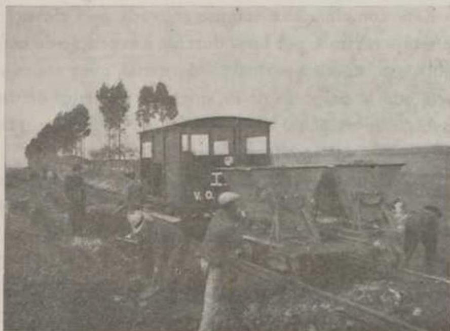
Carga e transporte rápido de balastro
