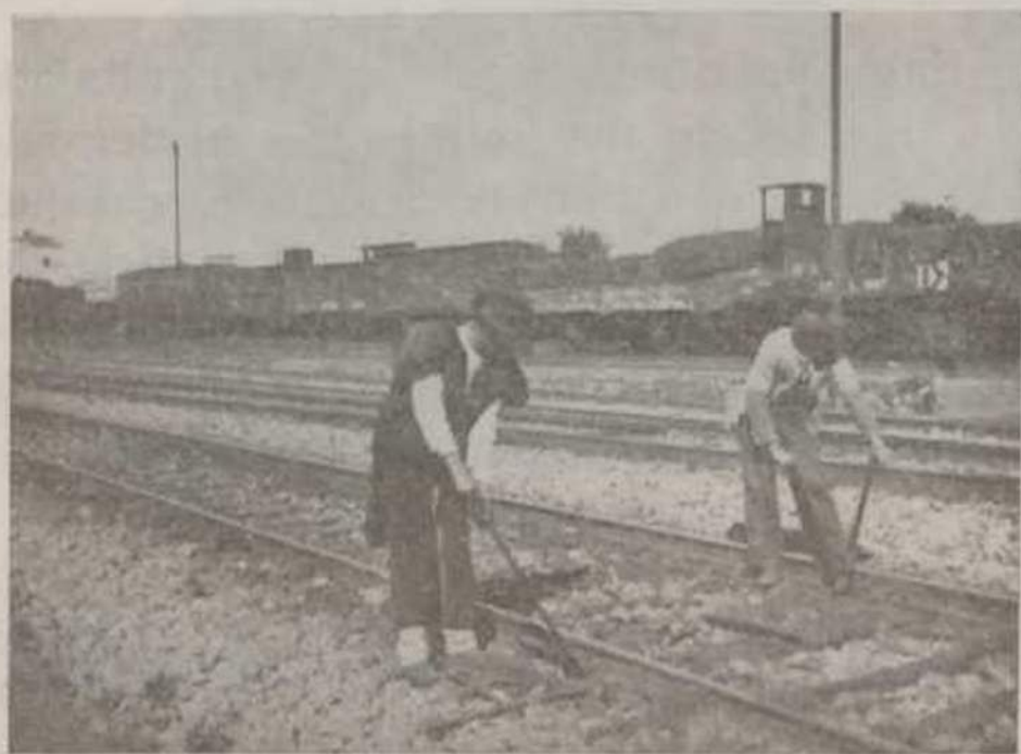
O emprêgo do novo aparelho para regularizar as juntas dos carris (à esquerda) e das chaves Robel (à direita) para parafusos de via, tornam o serviço rápido e económico.
