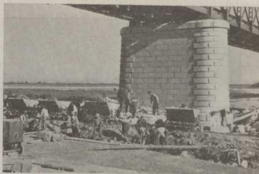
O antigo encontro da ponte da Vala da Azambuja transformado em pilar.
