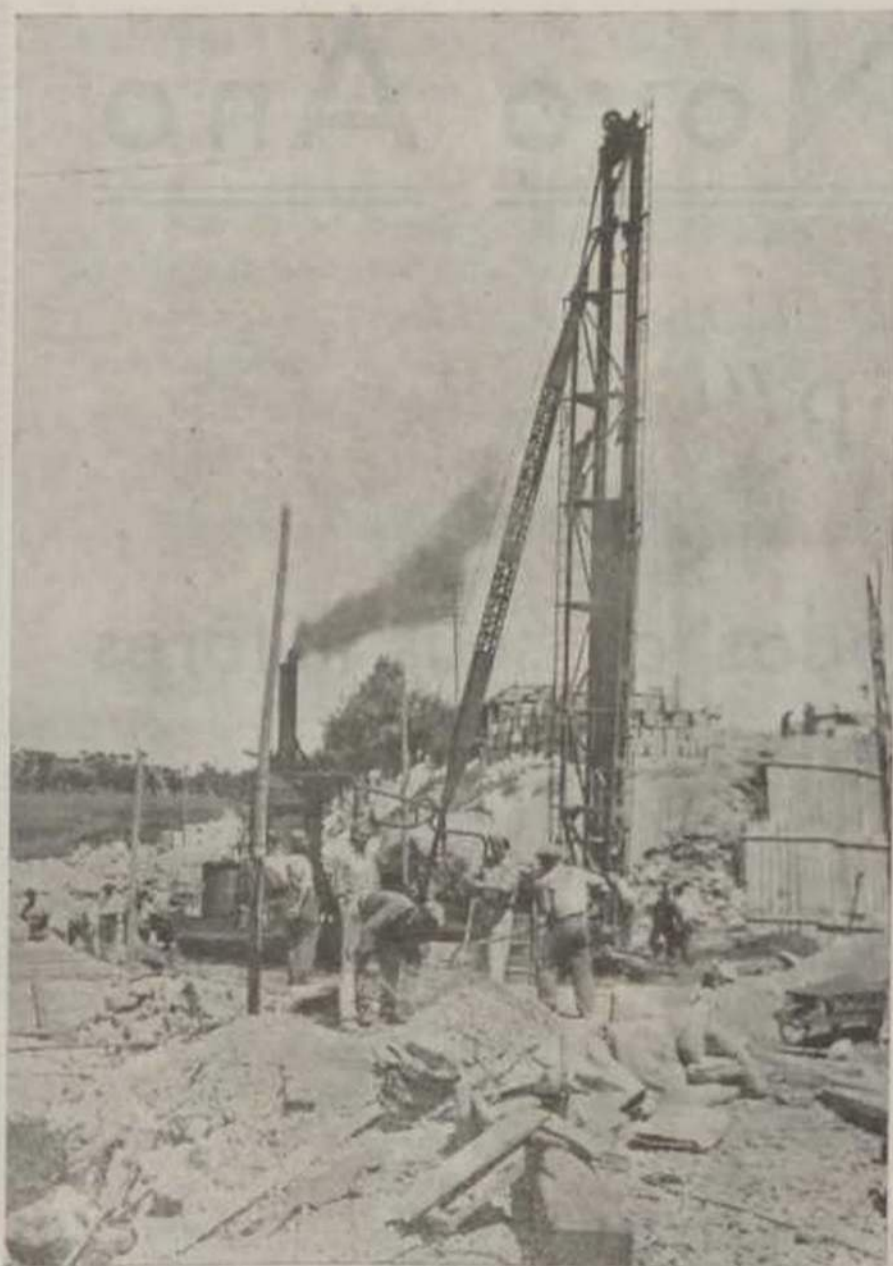
Grande máquina Franki a vapor, com lança de 17 metros de altura, para moldagem de estacas de formigão armado, no próprio terreno.
