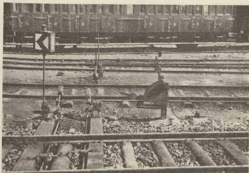
Tipos de caixas com manipulo de manobra de agulhas e sinais munidos de cabresto, cadeado Bouré e lanterna indicativa de posição de agulha.
