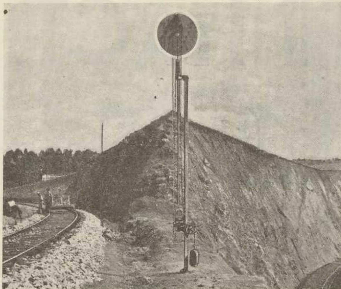
Disco avançado de manobra mecânica visto pelo tardo
