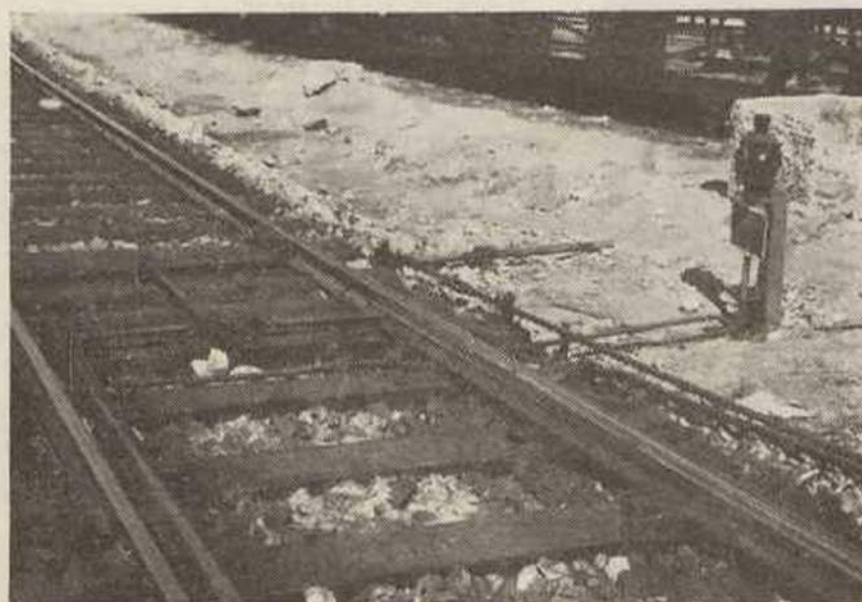
Agulha munida de pedal, ferrolho, lanterna e placa indicativa de posição de agulhas. Vêem-se as varas metálicas para manobra ligadas ao pósto central Saxby.
