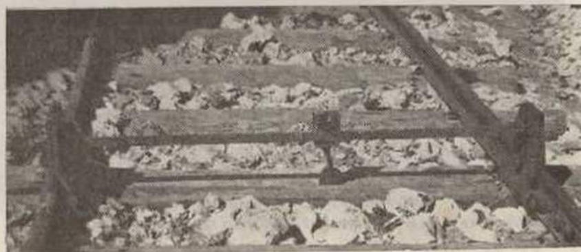
Calço limite com encravamento sistema Bouré . Vê-se o cabresto e o cadeado.
