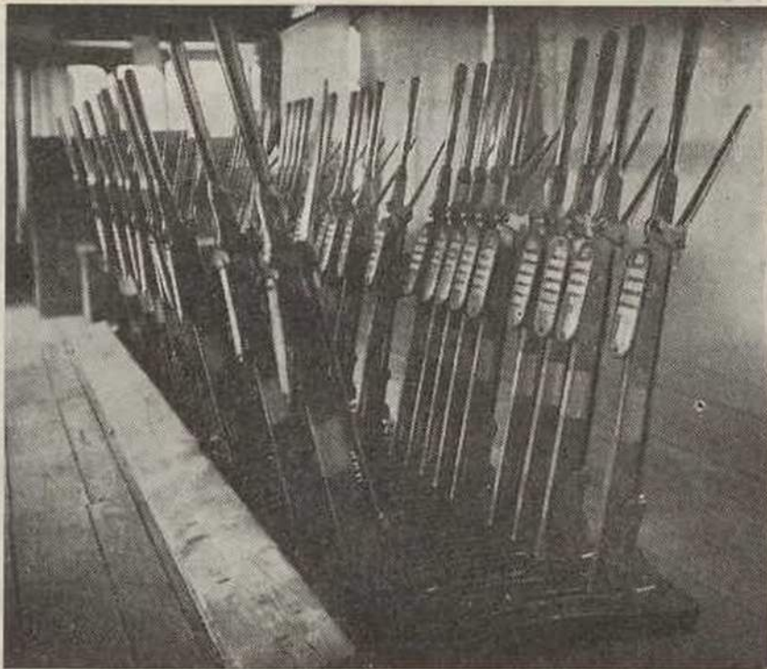
Interior dum pôsto de encravamentos mecânicos Saxby e Farmer . A bateria de alavancas de manobra de agulhas e sinais do velho pôsto da estação de Lisboa-R.
