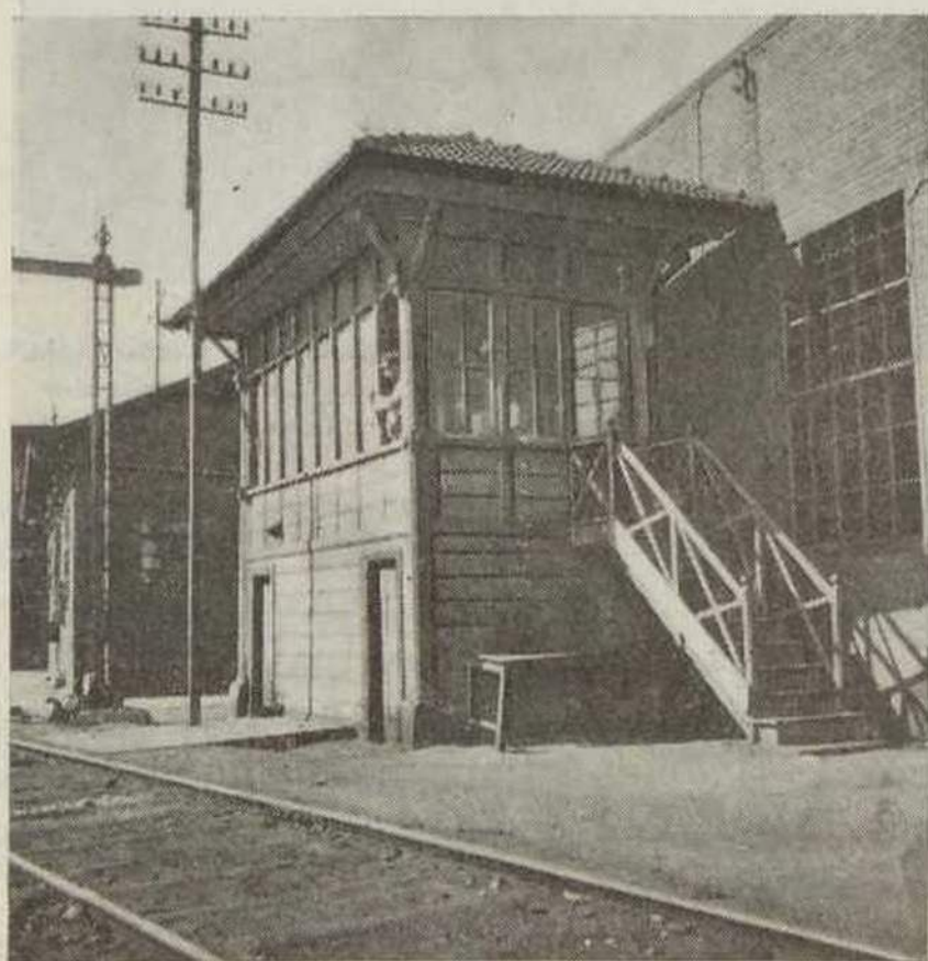
O velho posto de encravamentos mecânicos de agulhas e sinais tipo Saxby e Farmer , de Campolide.
