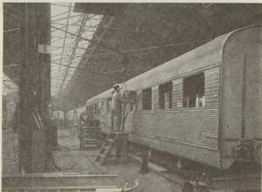
Soldadura do teto às laterais
